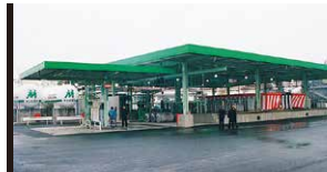
県内随一の最新鋭の設備を誇る栃木充填所
