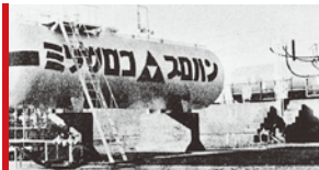
伊勢崎 LP ガスプラント設置
