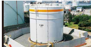
千葉に完成した5,000KLタンク
